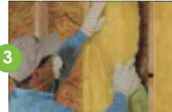
3 Instale TERMOFIBER entre los paraleles de la estructura.
