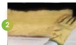
2 Sobreponga TERMOFIBER en la estructura del cielo raso, con perfiles para cielos o de ensamble automático para plafón registrable. Colóquela tope a tope sin traslaparla y evitando luces o dilataciones.
